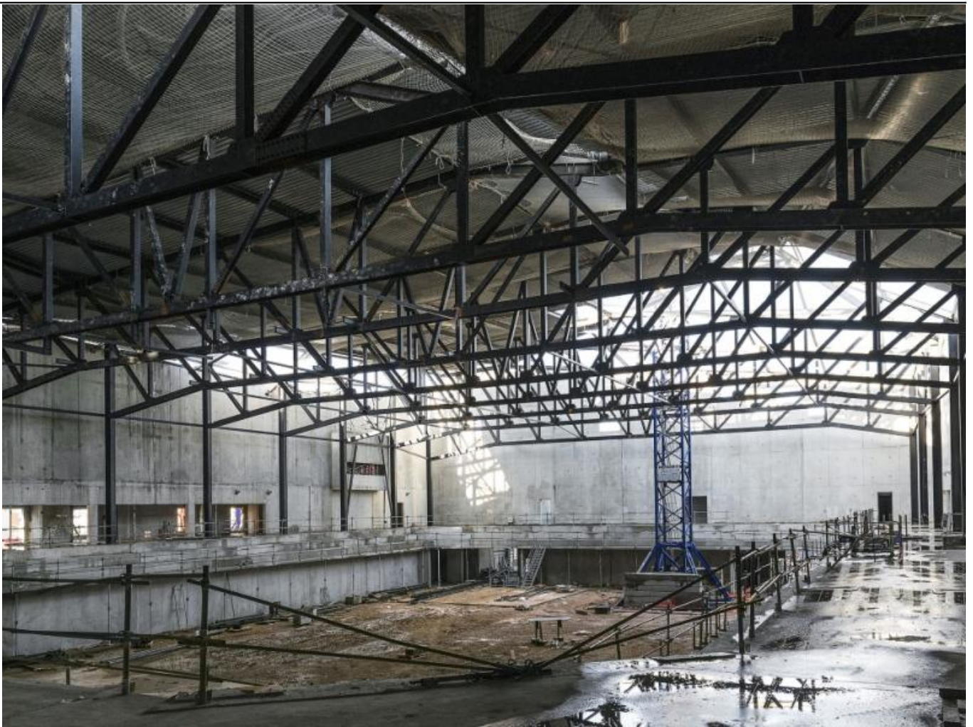
La charpente métallique salle du Jeu de Paume
